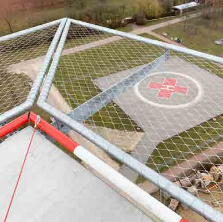
Plattform mit Unterzügen rund 7 t schwer (Stahlbeton zzgl. 55 t Stahl)
