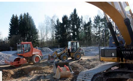
Anfang März rollten die Baufahrzeuge an für den Bau des neuen Wohnheimes in Bogen (siehe auch Seite 11)
