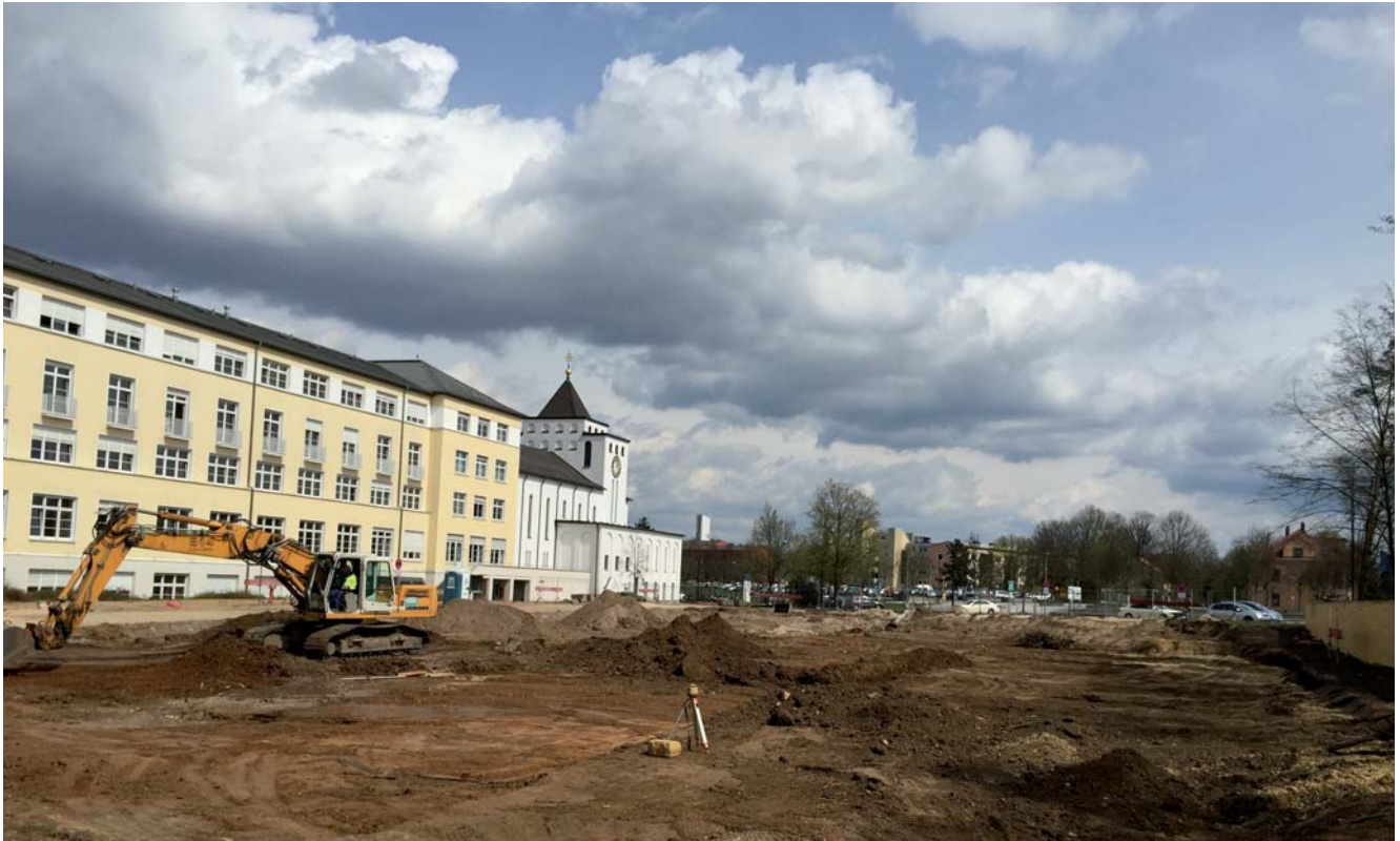
Blick auf die Baustelle: Die besondere Herausforderung für die Planung des Zentrums für Altersmedizin in Regensburg liegt in der unmittelbaren Nähe des Neubaus zum historischen Gebäudekomplex des Krankenhauses im Bauhaus-Stil und zur Kirche St. Pius.
