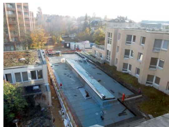
Neubau in der Regensburger Hedwigsklinik
